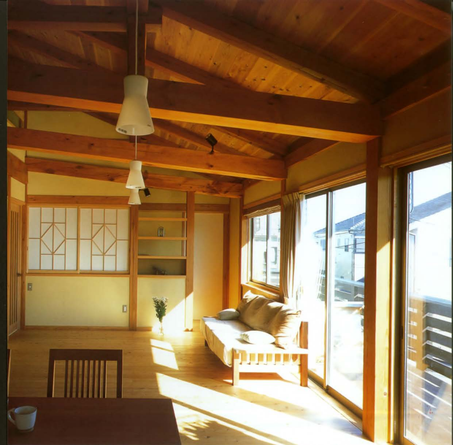
▲2階子世帯食堂から居間を見通す／建主はつくる過程にかかわりたいと、積極的に施工に参加。構造材の柿改塗、外部の黒色塗装、カウンターや上櫃の漆塗り、床の蜜蝋ワックス塗など、木部塗装のほとんどはご主人の手による
