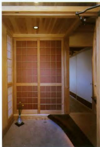
▲1階玄関廻り/施工中にオニグルミの大きな板との幸福な出会いがあった。その一部がこの上り框。ナチュラルカーブを最大限生かした木取りで初めから意図していたかのような出来であった(写真=木寺安彦)
